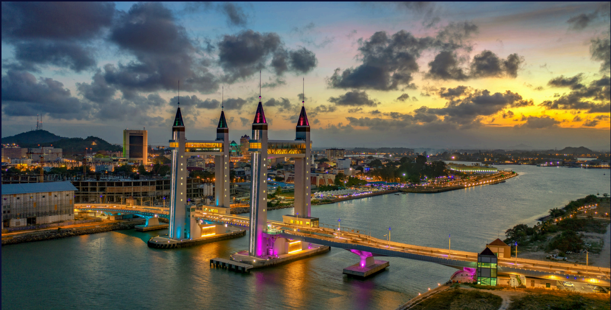
Kuala Terengganu, Malaysia
